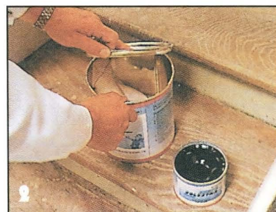
На старую ступень наносят специальный клей, служащий одновременно выравнивающей массой. Время отверждения клея — примерно 2 часа.
