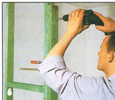
В дверном проеме ставят сдвоенные стойки из соединенных шурупами брусков.
