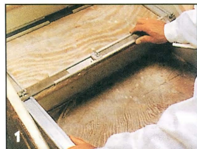
Сначала с помощью раздвижного шаблона измеряют старую ступень. Затем готовые элементы раскраивают и подгоняют по длине и ширине этой ступени.
