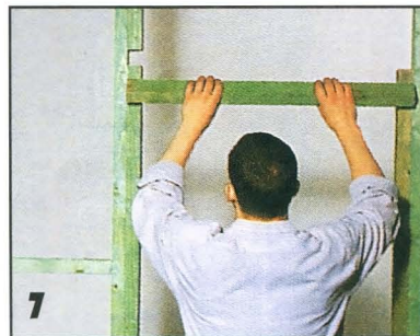
Перемычку над дверным проемом монтируют на высоте 2 м. Ее приворачивают шурупами на внутренних брусах сдвоенных стоек.
