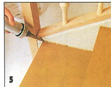
Швы между уложенным элементом, тетивами и подступенками заделывают эластичным герметиком.
