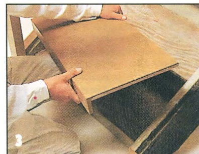
Готовый элемент устанавливают, держа его наклонно по отношению к подступенку, и аккуратно вдавливают в слой клея. По этой ступени нельзя ходить в течение 2 часов.
