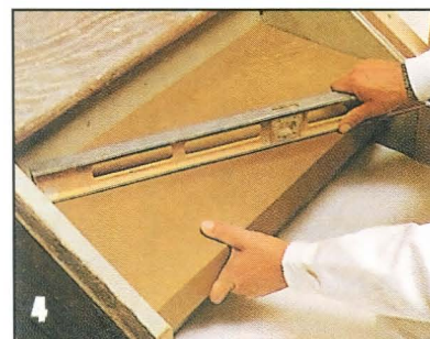
В течение 1-го часа, пока клей еще не затвердел, положение новой ступени можно подправить, проконтролировав правильность установки с помощью уровня.
