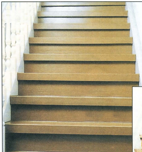
Так выглядит отремонтированная лестница.
